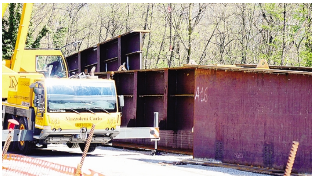
Operai al lavoro, il cantiere volge alle battute finali
