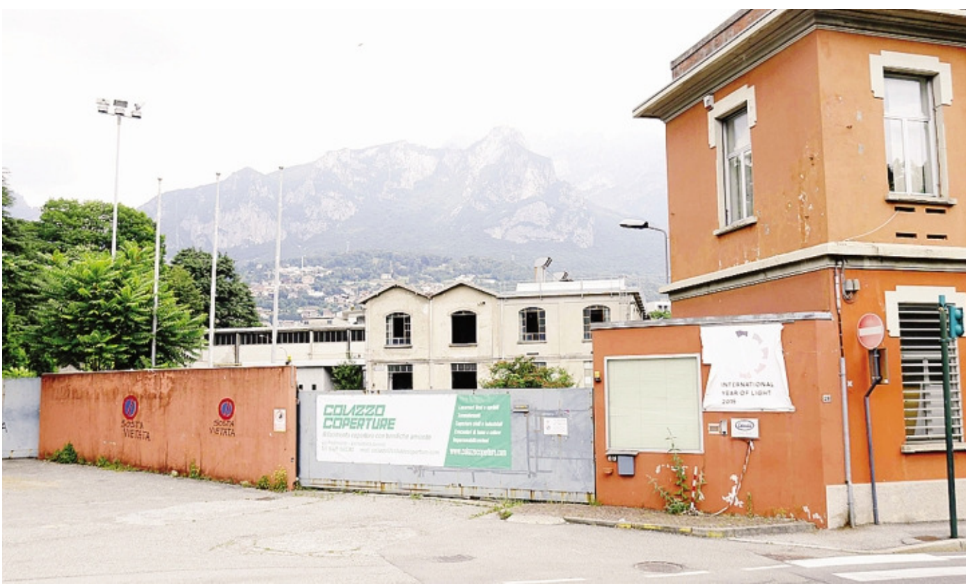
L'opera di bonifica all'ex Leuci è giunta ormai alle battute finali: l'intervento dovrebbe finire entro metà ottobre
