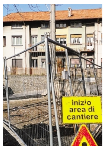
L'area del cantiere
