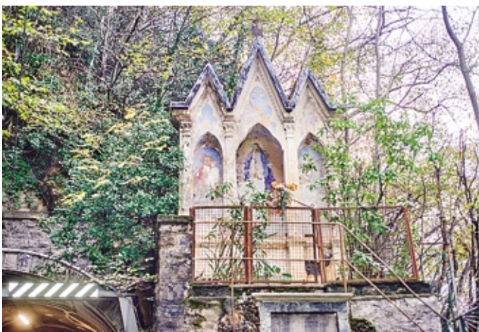
Le edicole che danno il nome al tratto di strada LOCATELLI
