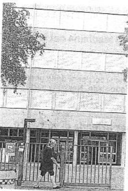
Lavori fatti coi fondi regionali
