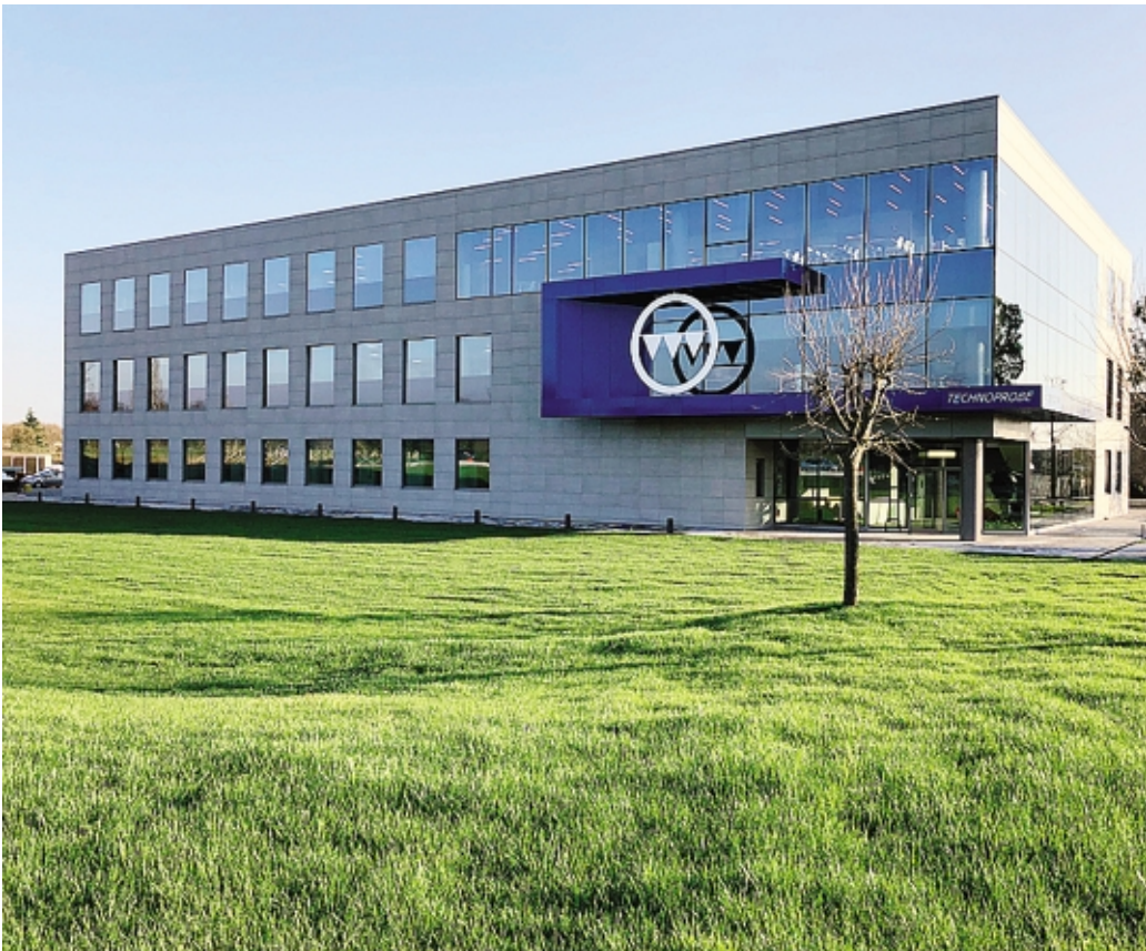
La sede della Technoprobe a Cernusco Lombardone
