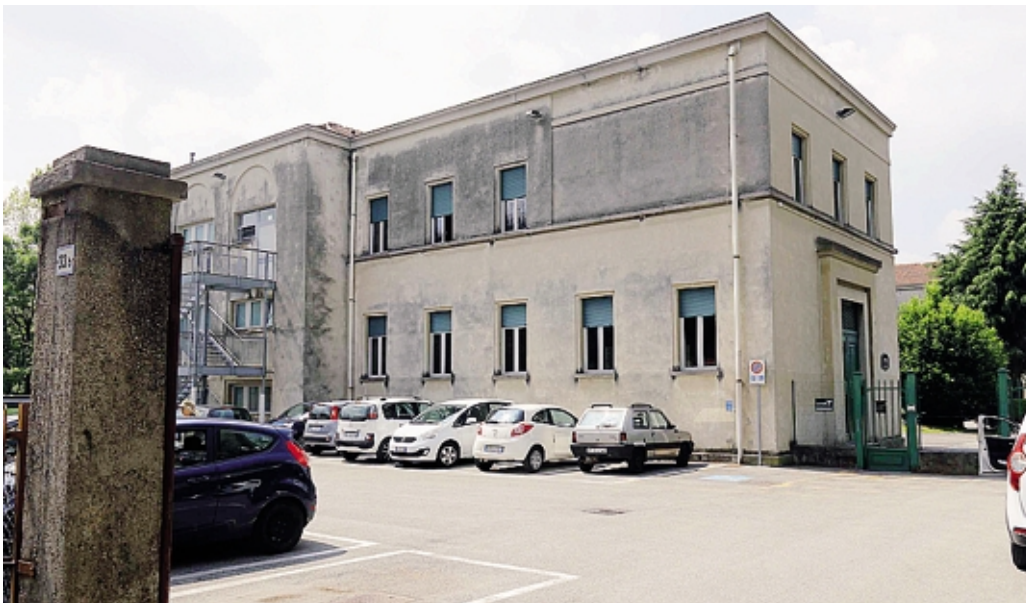
La scuola primaria Diaz, l'edificio risale agli anni Venti del secolo scorso
