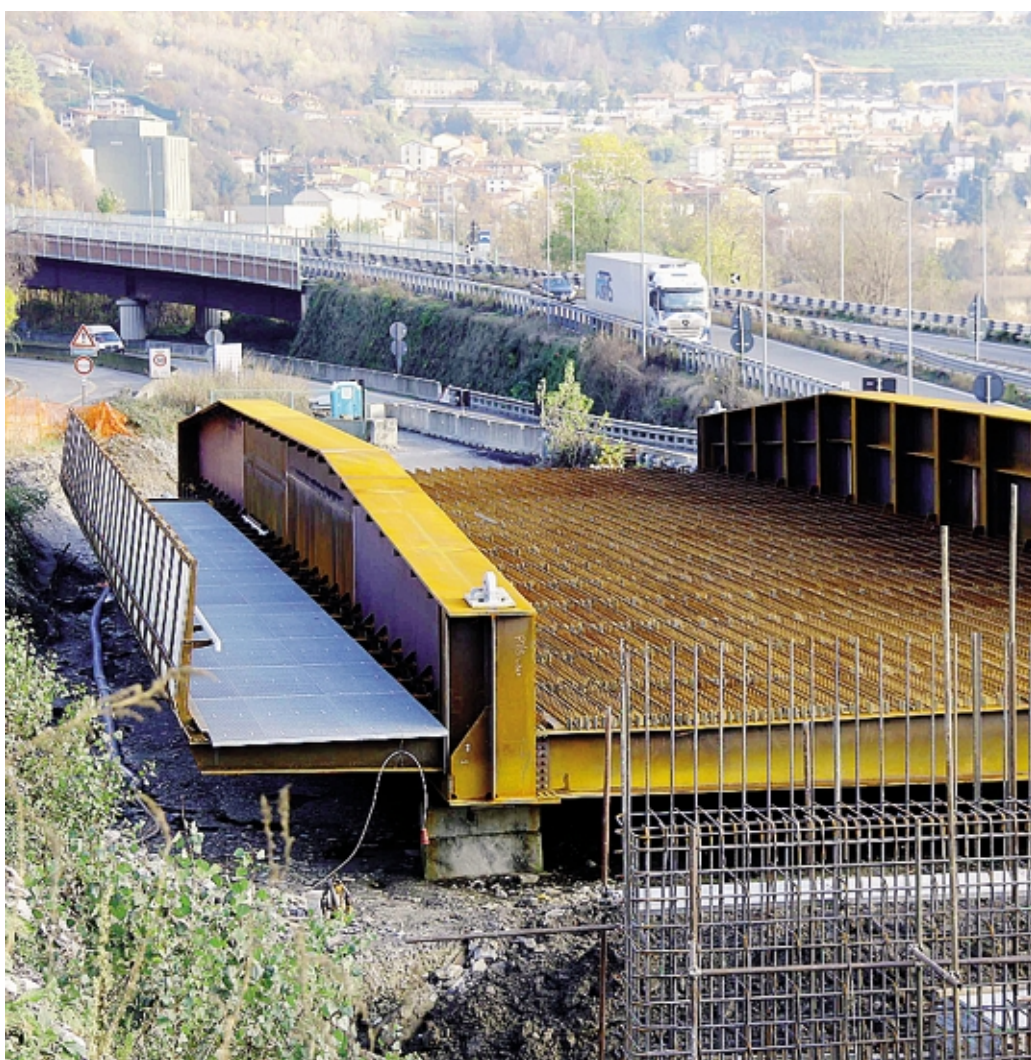
Il ponte quasi pronto in attesa di essere collocato a scavalco della superstrada 36
