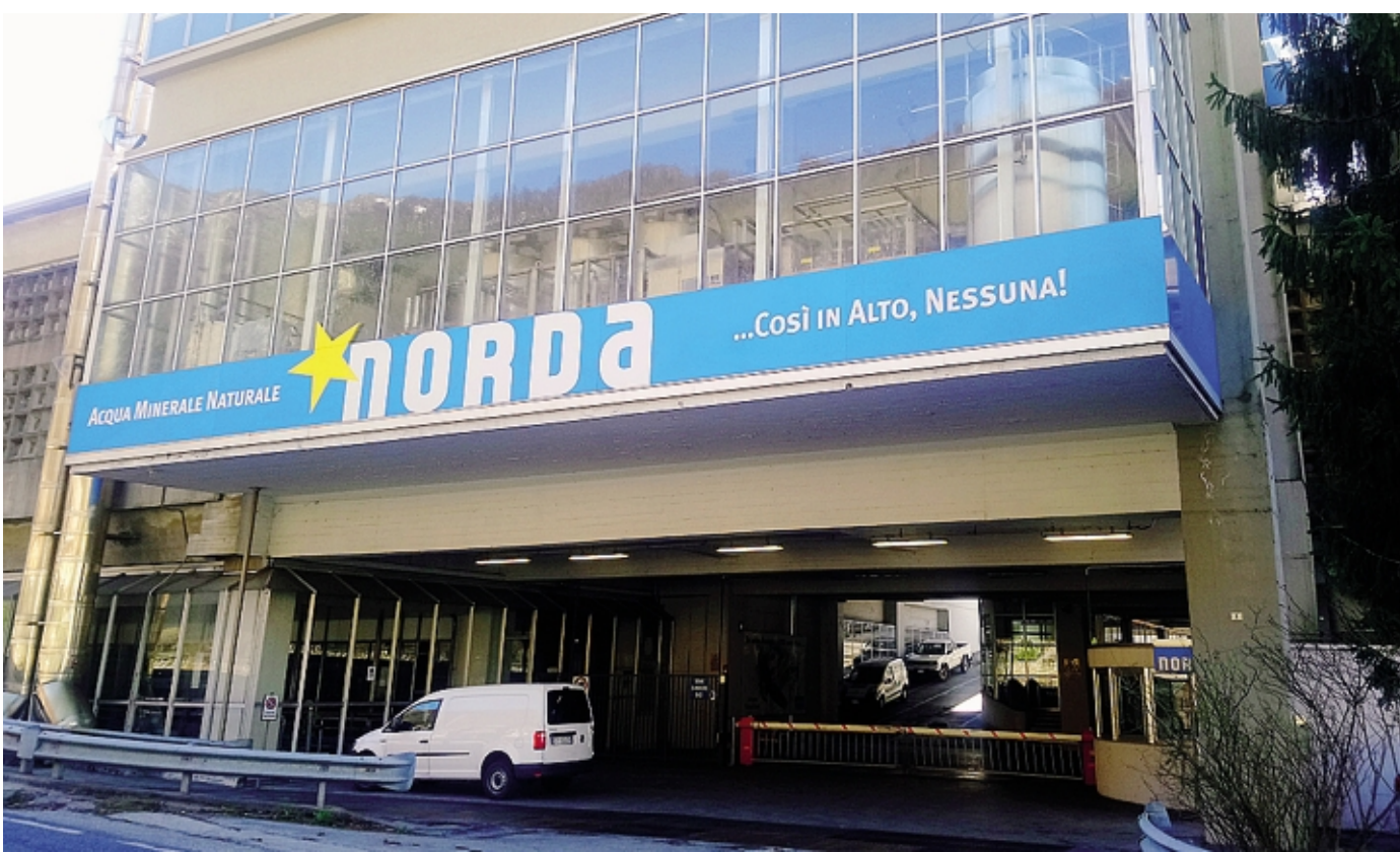
Lo stabilimento della Norda a Primaluna, vi lavorano ottanta dipendenti
