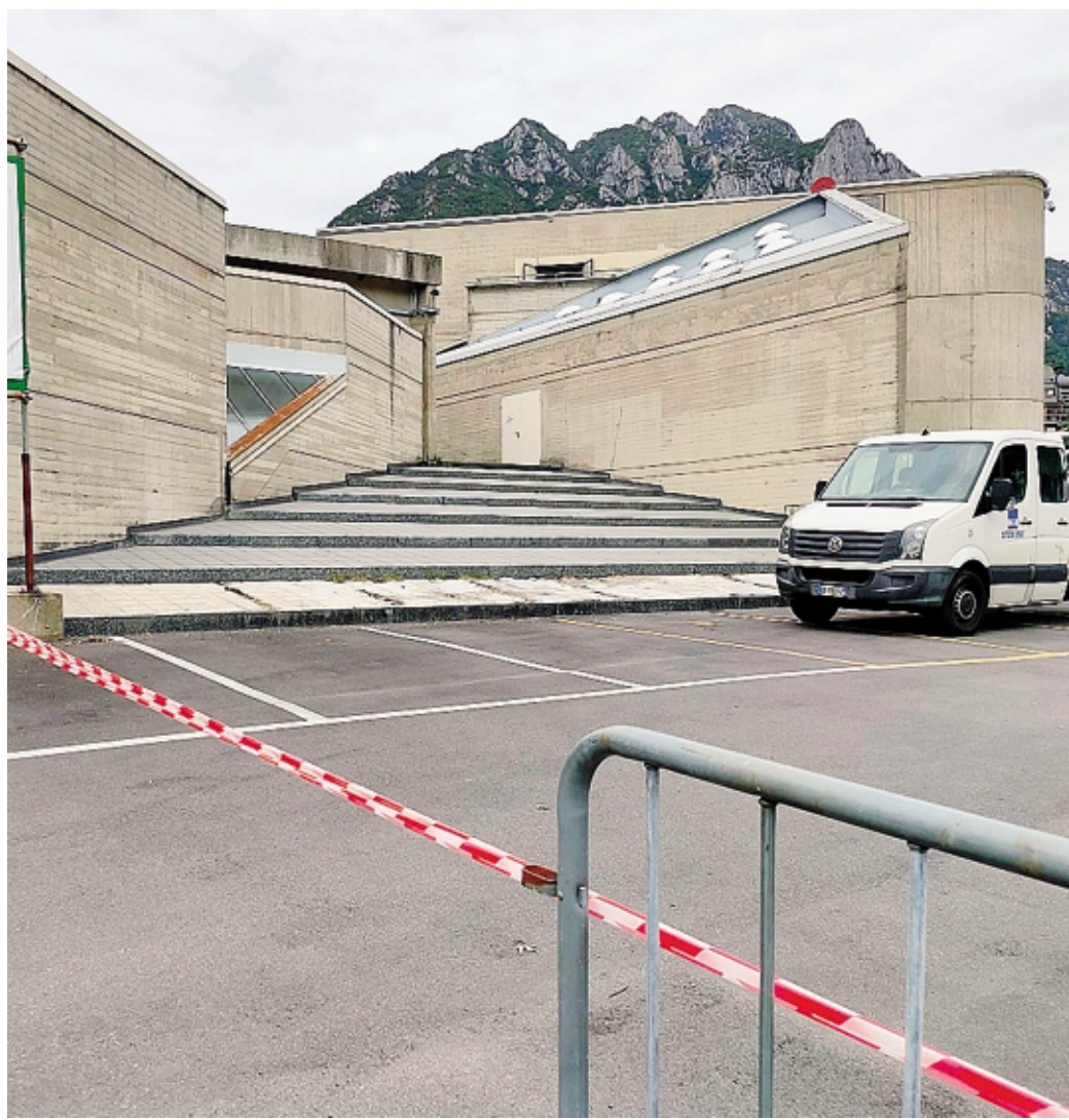
Il cantiere nell'immobile che ora accoglie una parte del Medardo Rosso e del Manzoni
