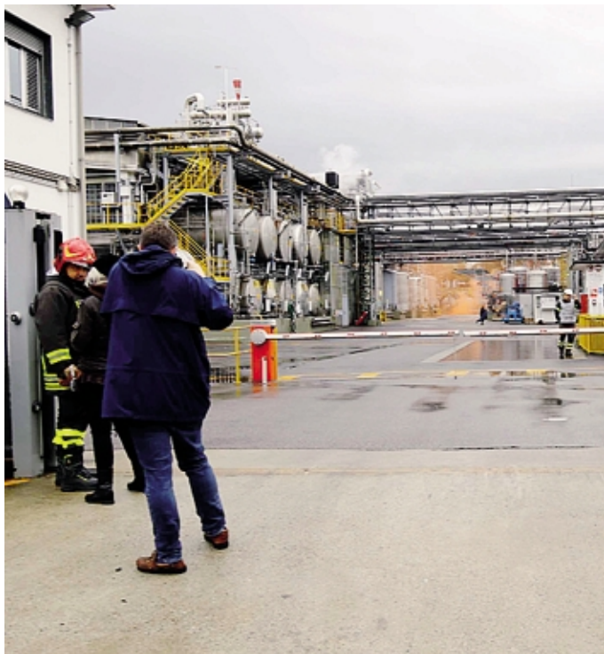
L'azienda chimica era stata a lungo osteggiata dai sindaci della zona
