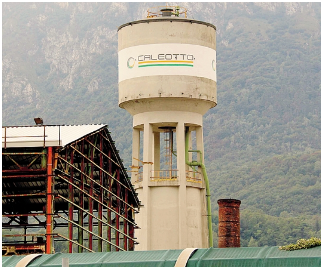
Il laminatoio del Caleotto è controllato al 100% dai bresciani di Feralpi
