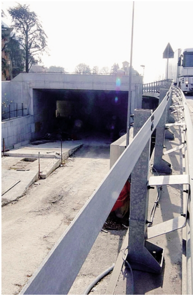
Il cantiere infinito della Lecco-Bergamo
