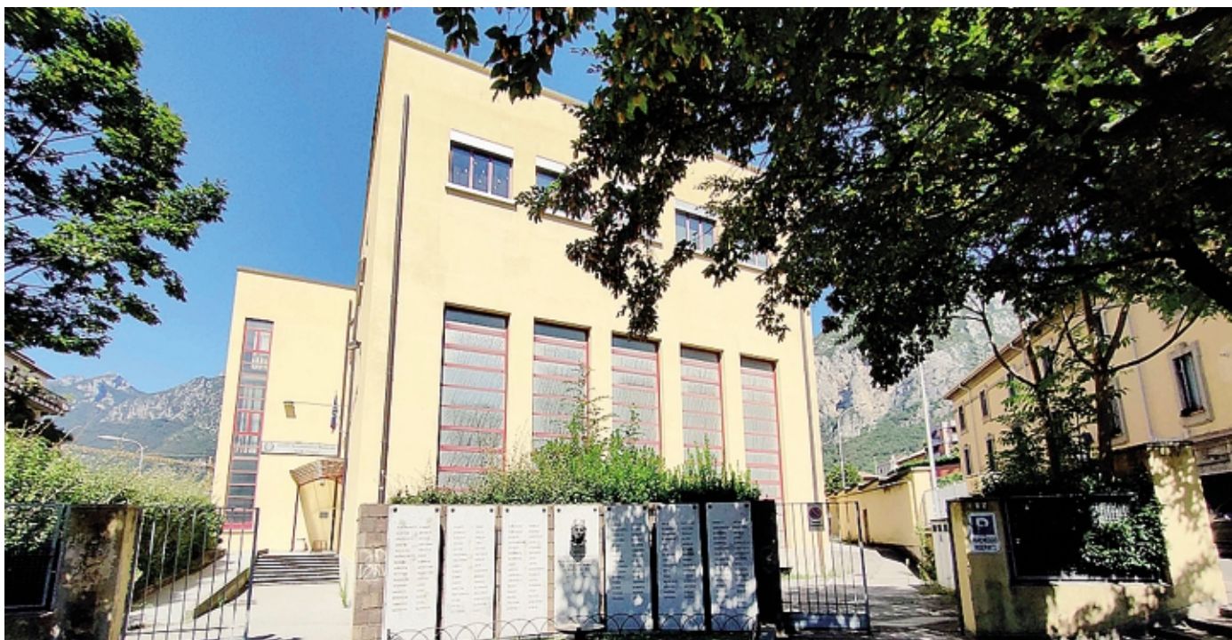
Lavori in corso in tutte le scuole lecchesi per gli adeguamenti necessari alle misure anti Covid
