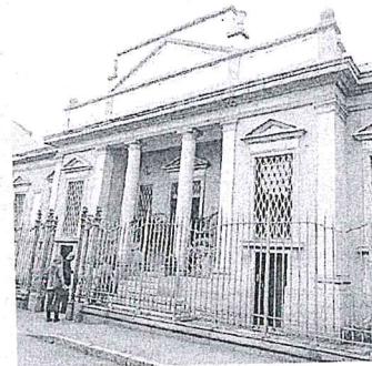
L'ex sede dell'Amministrazione provinciale in via Tommaso Grossi a Monza, ex fabbrica tessile «Pastori e Casanova». Dal prossimo anno ospiterà il Palazzo del lavoro
