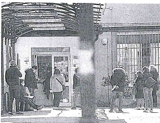
L'attesa dell'iniezione all'esterno dei padiglioni del vecchio ospedale
